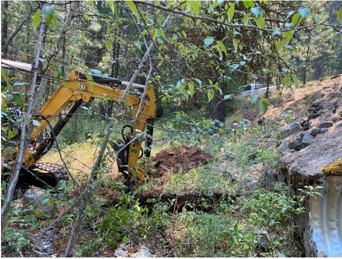
TP-3, looking SE
